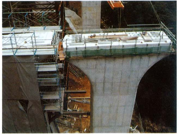
高速道路橋梁下部工
