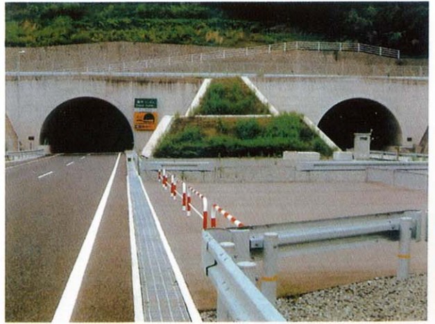
トンネル二次覆工工事
