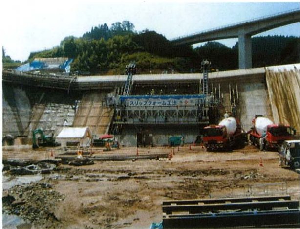
ダム遮水壁工事
